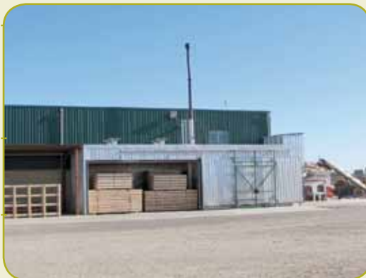
Figure 31. Vue de la chambre de traitement. Source: ONA
