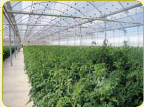
Figure 25. Vue de l'intérieur de la serre: Source: CENER
