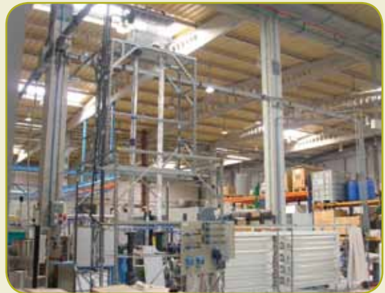
Figura 27. Vista general de la instalación. Fuente: Gaiker
