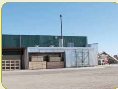
Figura 31. Vista de la cámara de tratamiento. Fuente: ONA
